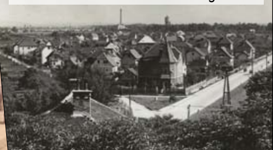
Don Bosco Kirchturm Blickrichtung Süden
